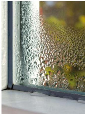
Feuchtigkeit in der Wohnung und als Ergebnis ein erhöhter Energiebedarf: Ein Austausch alter Dichtungsprofile ist dann oftmals unerlässlich.
